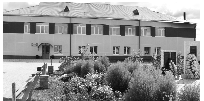
* Дом культуры после ремонта
