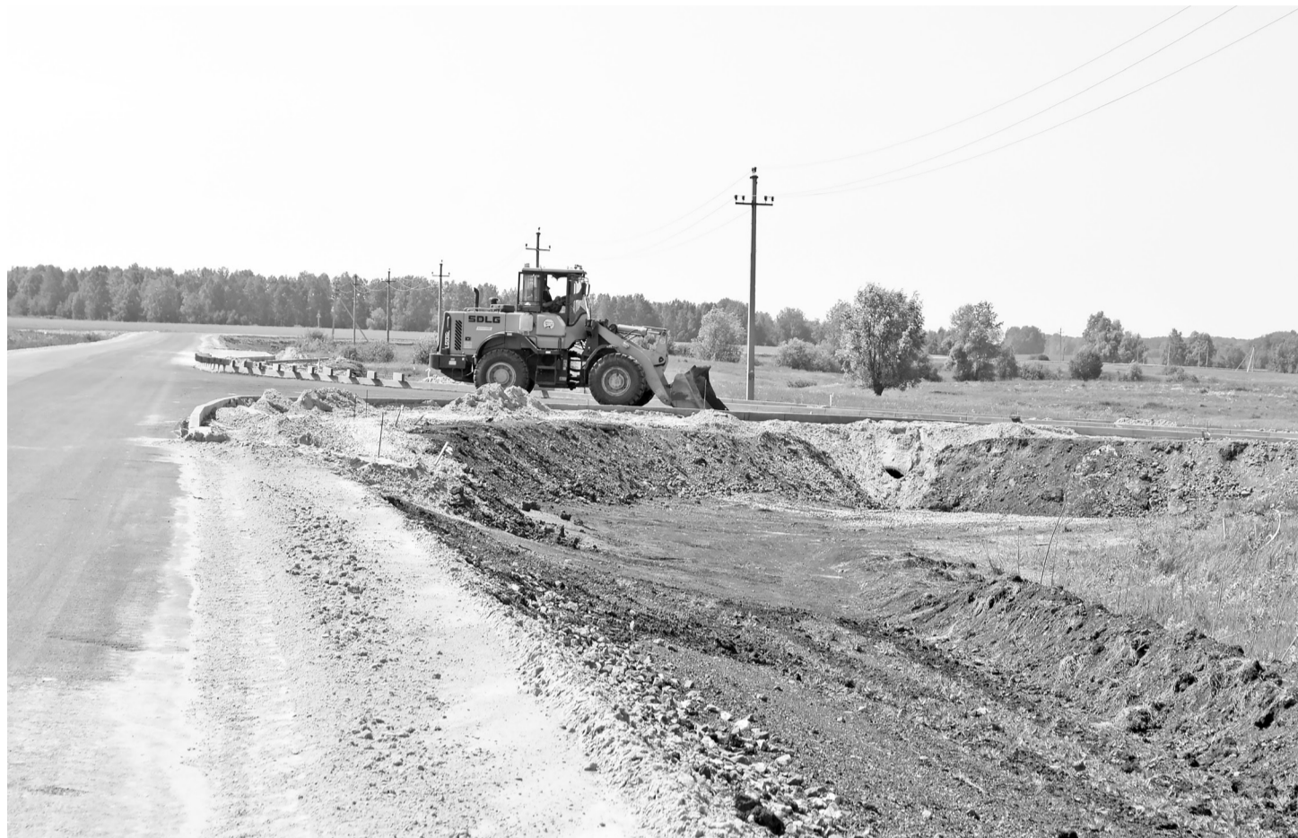
Капитальный ремонт автодороги Нижняя Тавда – Новотроицкое. Сельскую дорогу не узнать.
