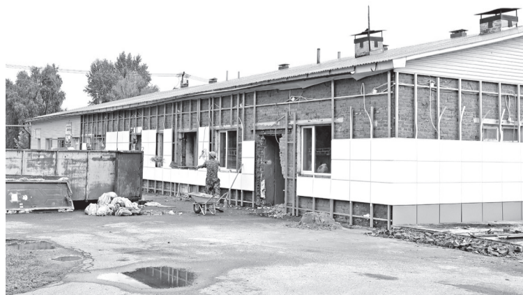
• В бане «Нептун», что на улице Совхозной в Заводоуковске, ремонт в самом разгаре. Завершить его рабочие планируют уже в августе.
