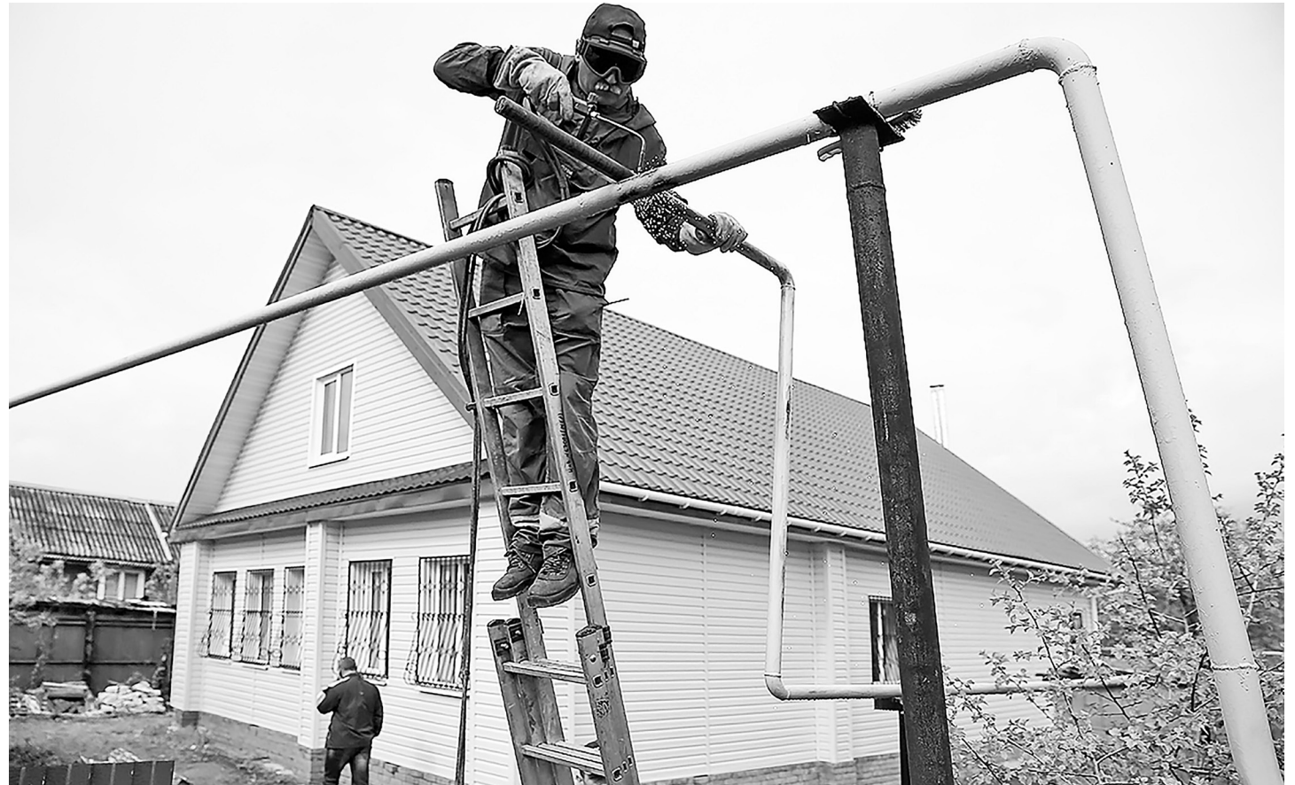
Идёт монтаж системы газопровода.
