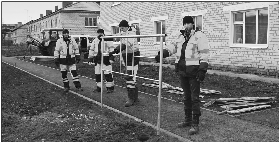
Дорожники ведут обустройство пешеходного перехода на перекрестке улиц Кирова и Свердлова
