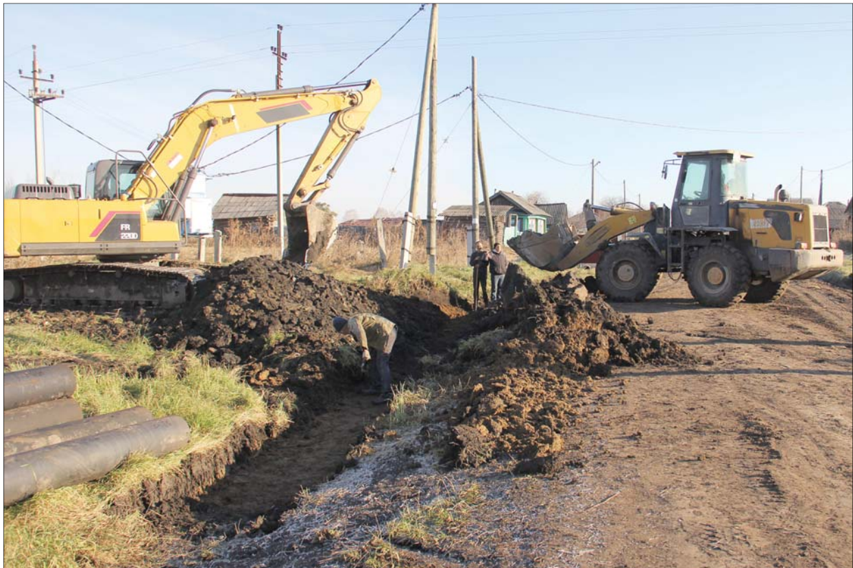
Уложенные трубы позволят увести воду с улицы после обильных осадков.
