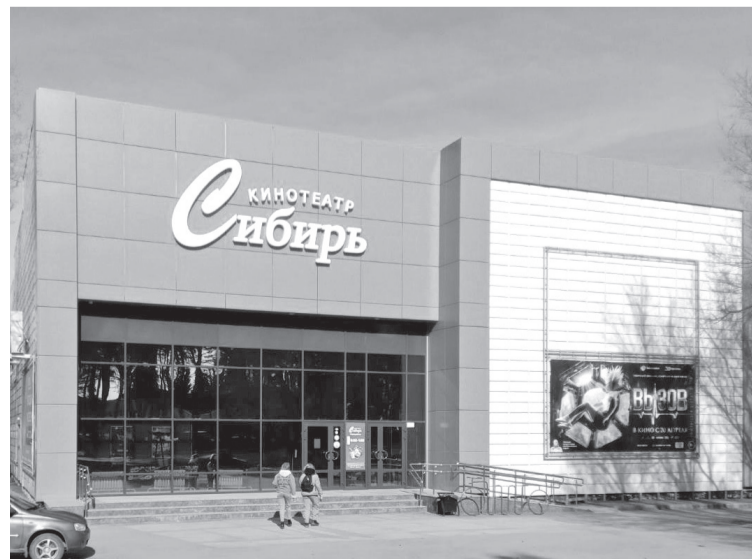
• После реконструкции, проведённой пять лет назад, здание отвечает самым последним требованиям кинопроката.
