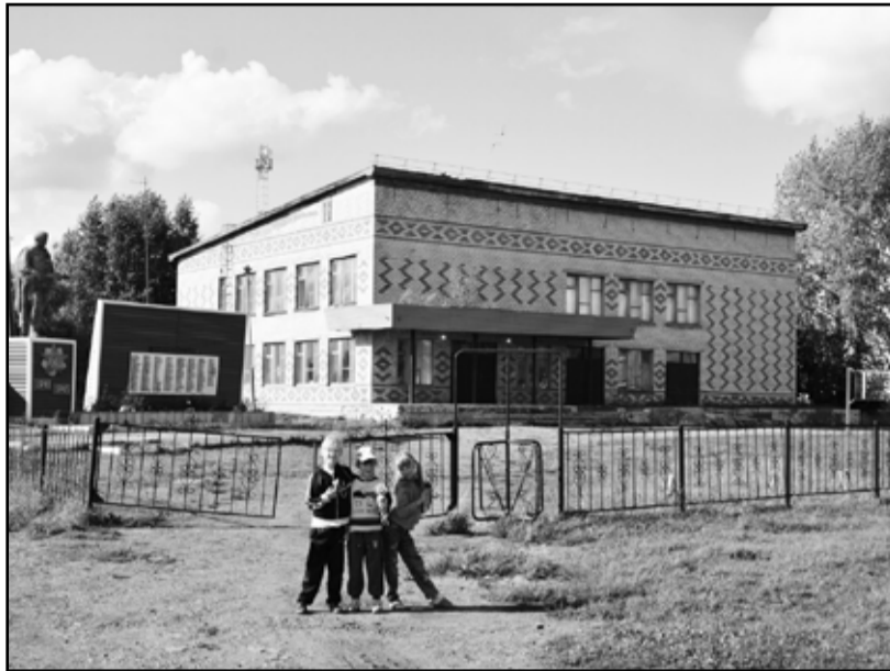
В недалёком будущем Челюскинский дом культуры обретёт новый вид. Деньги на капитальный ремонт из бюджета выделены
