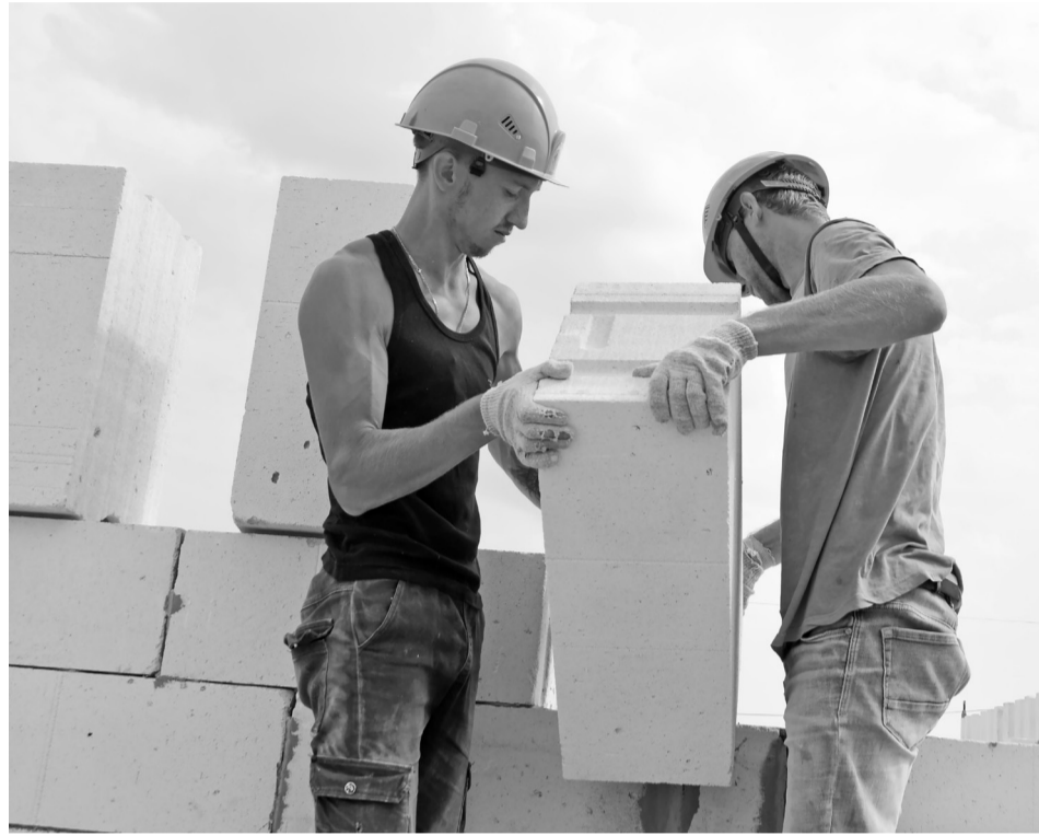
Иван Казека и Валерий Хаченко (справа) устроились помощниками каменщиков. После окончания стройки они, наверняка, приобретут много полезных навыков.
