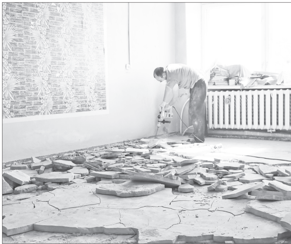
В терапевтическом отделении удаляют старую стяжку пола. Рядом каменщики строят перегородки. / ФОТО АВТОРА.
