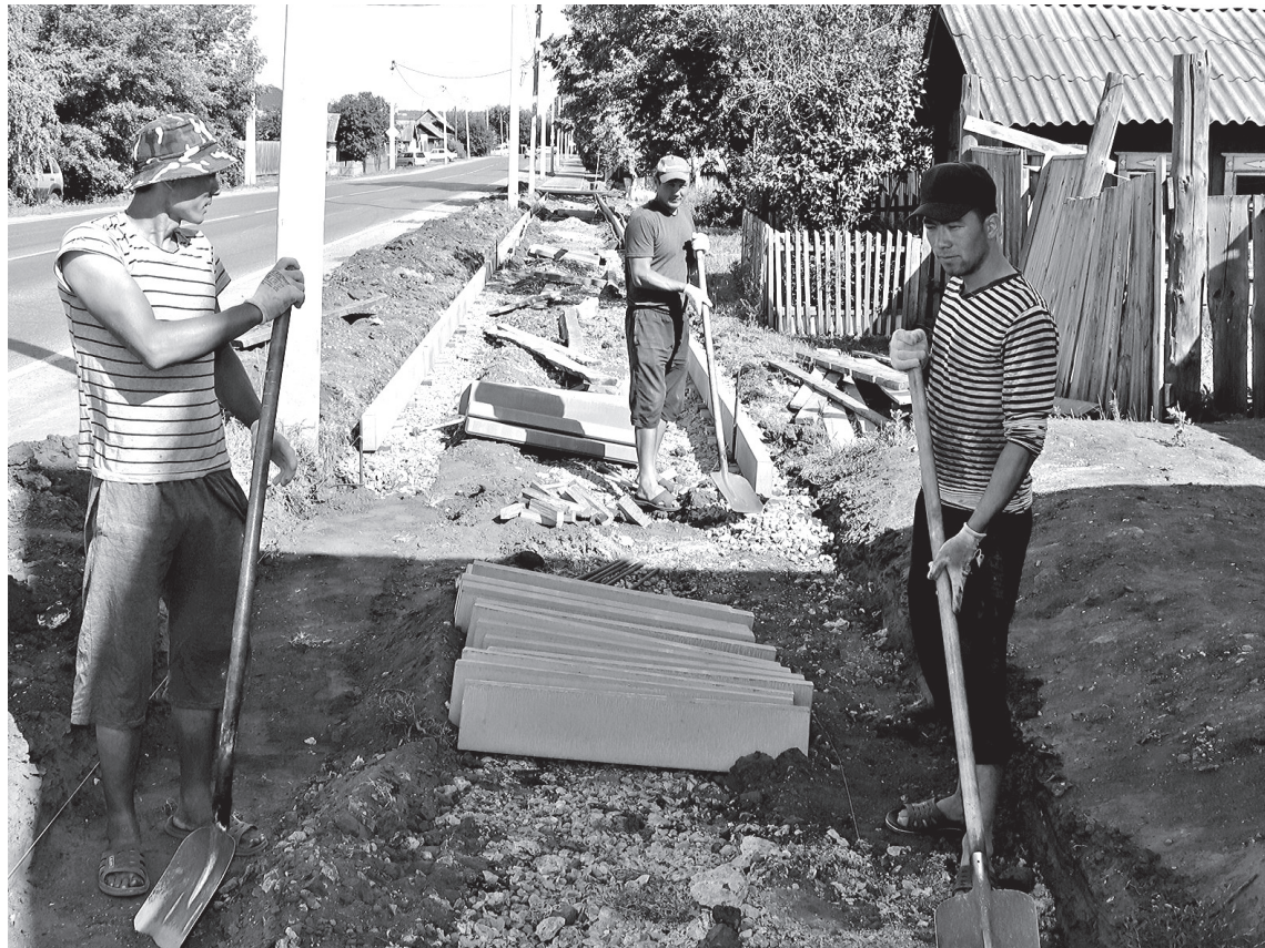
• Строительные работы на улице Шоссейной в городе в самом разгаре. Новый тротуар обеспечит пешеходам комфорт и безопасность.
